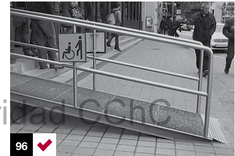
Foto 96: rampa provisoria a antigua estación de trenes indicando la necesidad de asistencia por su pendiente. Augsburg, Alemania.
