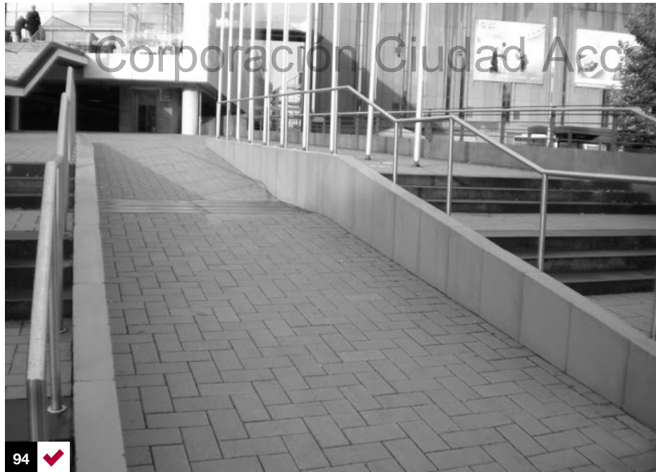
Foto 94: rampa alternativa a escaleras en acceso a recinto. Feria Colonia, Alemania.
