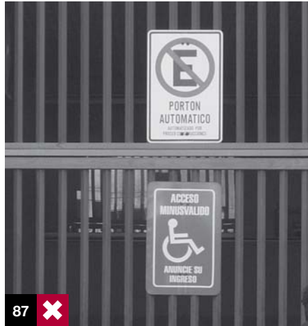
Foto 87: un acceso a través de la rampa de estacionamientos no es considerado un acceso válido bajo ninguna circunstancia, aun cuando esté señalizado. Antofagasta, Chile.
