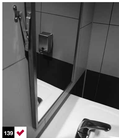
Foto 139 y 140: espejo que permite ser inclinado para mejorar el reflejo a una persona sentada. El uso en ambas posiciones le da características universales.
