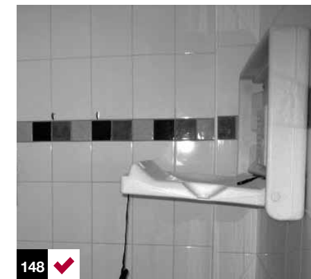
Foto 148: los mudadores también deben contemplar instalación a una altura adecuada para ser usados por todas las personas.
