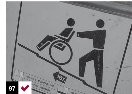
Foto 97: señalización de rampa con pendiente sobre lo recomendado indicando la necesidad de ayuda de terceros. Venecia, Italia.
