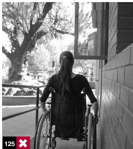
Foto 125: las ventanas que se sitúan a un costado o sobre una rampa deben abrir hacia adentro o ser de corredera.
