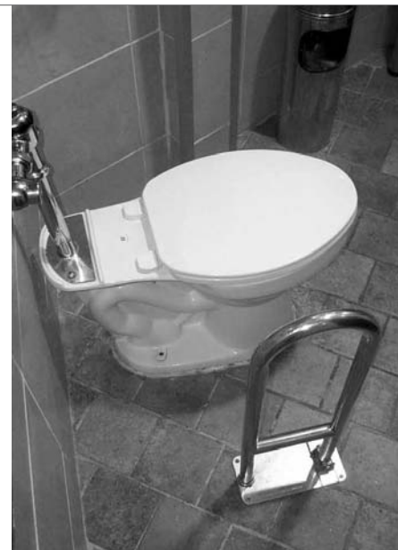
Foto 135: barra de muro instalada al piso. No cumple su función.
