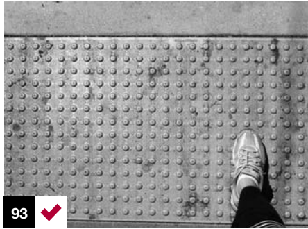
Foto 93: textura de alerta de 80 cm de profundidad para avisar cambio de nivel e inicio de rampa. San Francisco, EE.UU.
