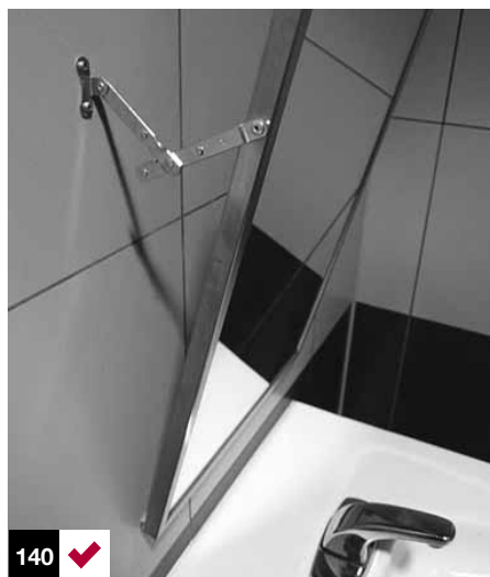
Foto 139 y 140: espejo que permite ser inclinado para mejorar el reflejo a una persona sentada. El uso en ambas posiciones le da características universales.
