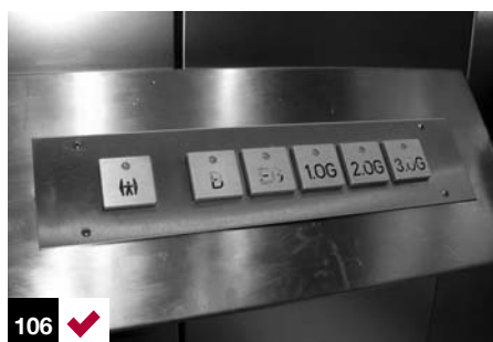
Foto 106: botonera horizontal de fácil alcance y detección.
